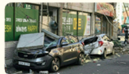
낙하물 차량 파손
